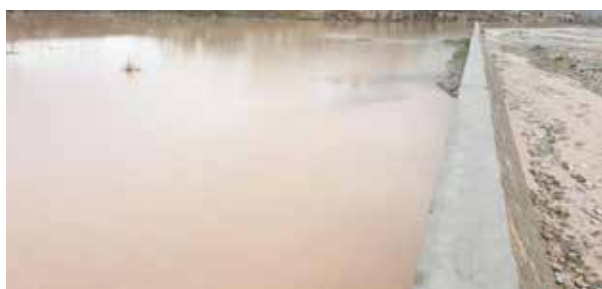
جمع شدن آب در پشت دیوار استنادی
