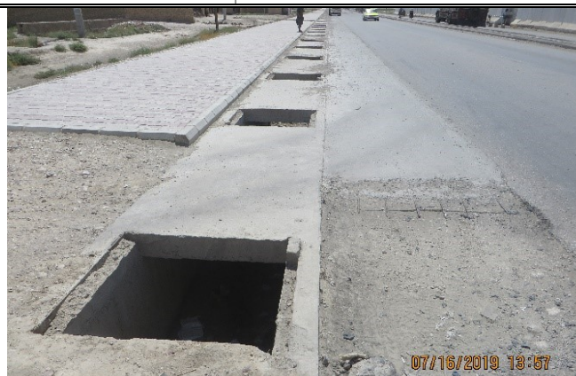
شکل: 11: با وجود اتمام کار جویچه‌ها، سرپوش‌های آهنی جویچه‌ها شکل: 12: فاصله مناسب بین میله‌های آهن و قالب خندق‌ها در نظر نصب نشده است. گرفته نشده است.
