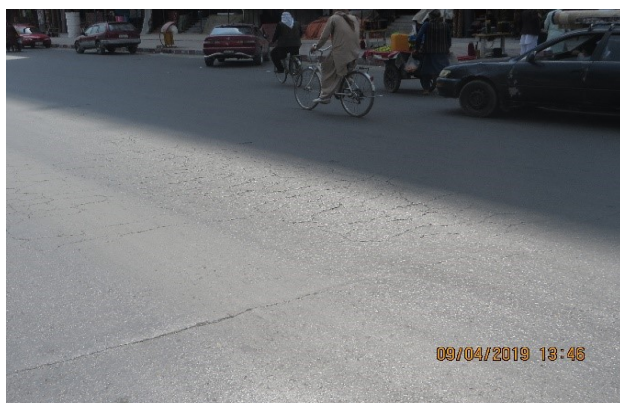
شکل 29: درز های عمده (ترک خوردگی) در تمام طول سرک قابل مشاهده است؛ درحالی‌که پروژه در سال دوم ساخت‌وساز آن است.
