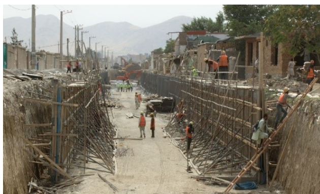
شکل 26: پروژه در قسمت 4 + 430 تحت قالب کاری و سیخ بندی قرار دارد.
