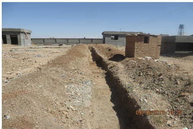
شکل 24: هیچ‌گونه نوار هشدار در اطراف آبروهای حفاری شده و مخزن سپتیک استفاده نشده است.
