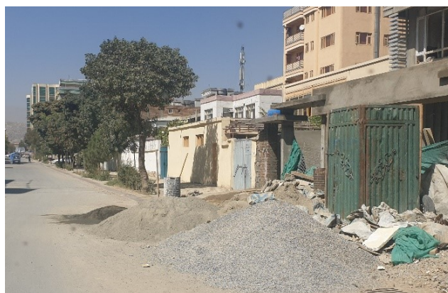
شکل 30: عدم نظارت شهرداری کابل پس از ساخت زیربنای عامه و سوءاستفاده توسط مردم
