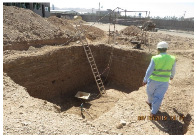
شکل 24: هیچ‌گونه نوار هشدار در اطراف آبروهای حفاری شده و مخزن سپتیک استفاده نشده است.
