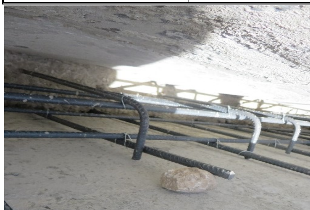
شکل: 11: با وجود اتمام کار جویچه‌ها، سرپوش‌های آهنی جویچه‌ها شکل: 12: فاصله مناسب بین میله‌های آهن و قالب خندق‌ها در نظر نصب نشده است. گرفته نشده است.
