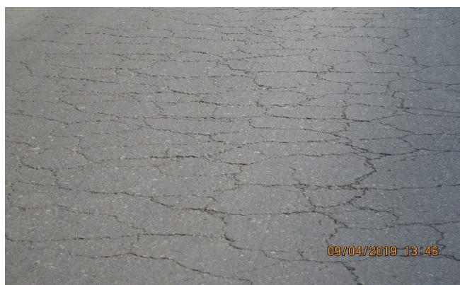
شکل 29: درز های عمده (ترک خوردگی) در تمام طول سرک قابل مشاهده است؛ درحالی‌که پروژه در سال دوم ساخت‌وساز آن است.
