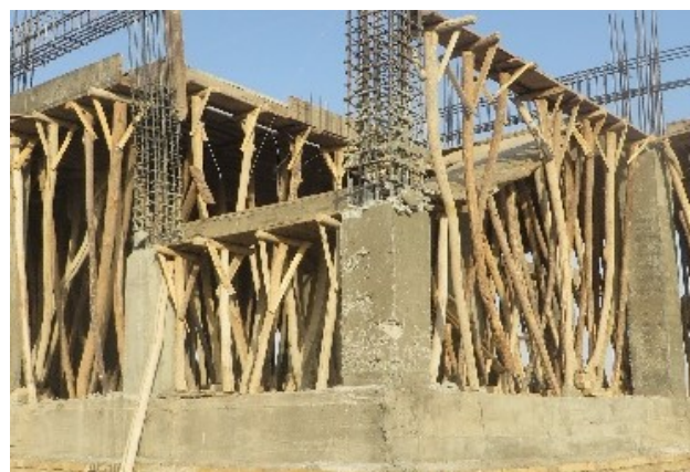
شکل 23: قالب‌کاری نادرست و عدم استفاده از فاصله‌انداز [spacer]: ایجادکننده فاصله میان قالب‌های کانکریت به منظور جلوگیری از زنگ‌زدگی باعث برهنه شدن میله‌های فولادی در دیواره‌های پارت امتداد دیوار در نوک سقف ساختمان‌ها برای ایجاد مصونیت پیش‌تر شده است.
